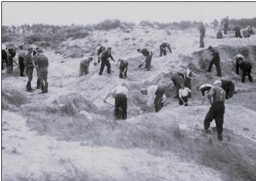
De gravers aan het werk op 1945. (HGA)
